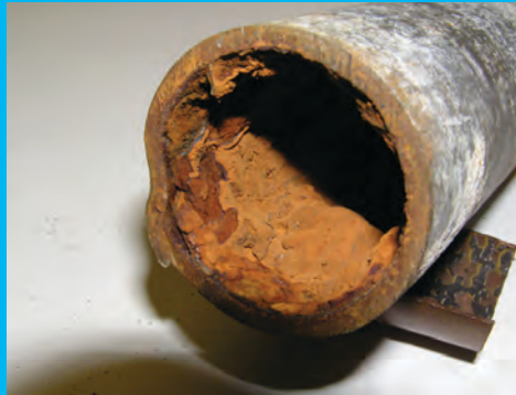
Korroosiolle altistunut putki.
