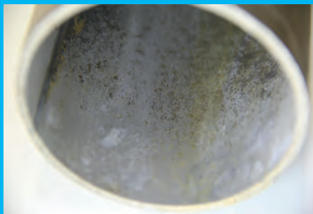
Puhdistettu uusi putki
